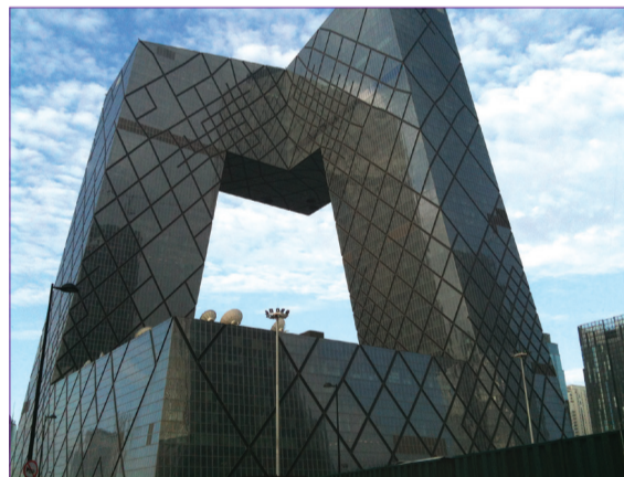
北京中央電視臺大樓實驗 Deployment in the CCTV Building
