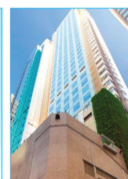
位於香港的酒店： 空調系統省電逾 25% Hotel in Hong Kong: 25% of air- conditioning system energy saving
