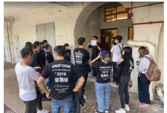
「裝修佬」招募一眾裝修師傅，自發為 Y2 型屋苑提供免費渠道及排氣管檢查及簡單維修服務。
