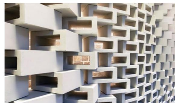
由回收玻璃再造的绿色生态建筑材料“环保再造砖”，有助抑制碳排放，转废为用。
