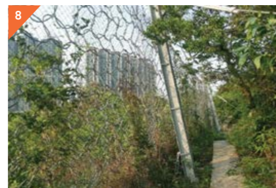
Flexible barriers installed at a slope site in Hong Kong 安裝在香港一個斜坡上的防泥石柔性網
