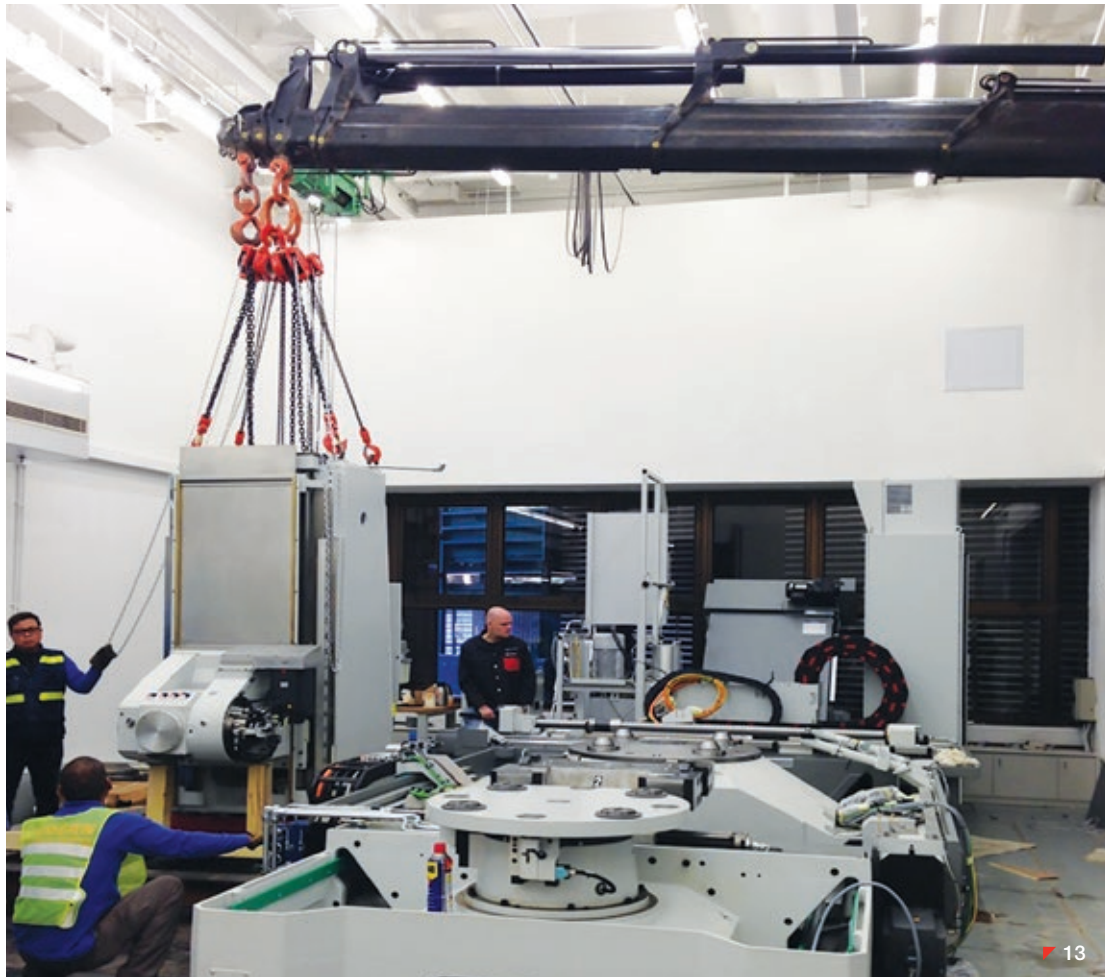
Installing starrag 5-axis machine 安裝 Starrag 五軸機情況
