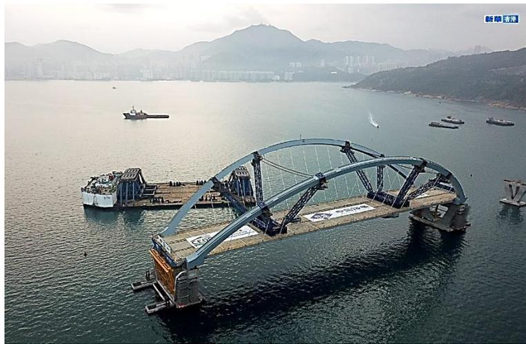
图 12： 钢桥被安放于预制桥墩上
