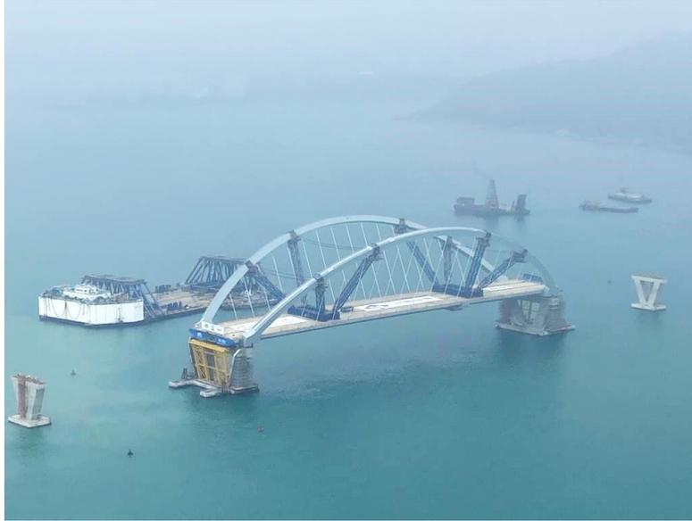
将军澳跨湾连接桥总共使用了 4,400 吨 S690 钢板制作两个弯曲的箱形截面，其横截面尺寸从 3.0 x 3.0 到 3.5 x 3.5 m 不等。
