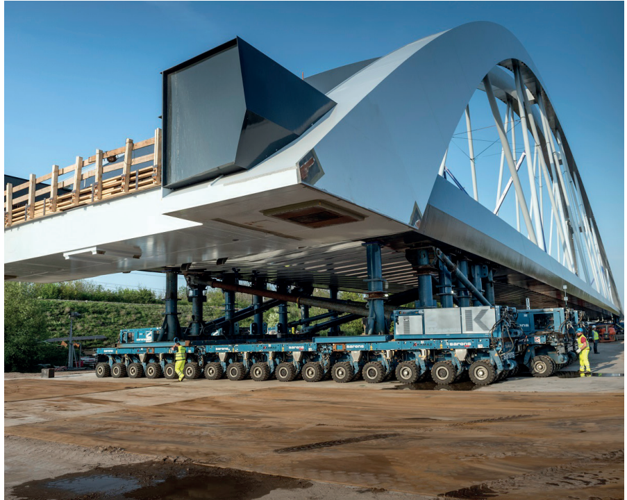
图7 使用自行式模块化平板车将桥梁移动到 A1 上方 资料来源: Iv-Infra b.v.
