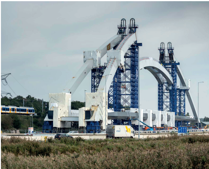
图 4 使用钢绞线千斤顶组装拱形结构 资料来源：lv-Infra b.v.
