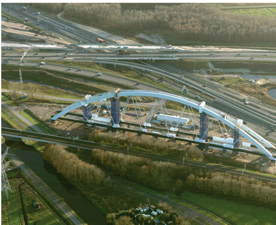
图 5 在 A1 公路旁组装 Zandhazen 桥 资料来源：Rijkswaterstaat
