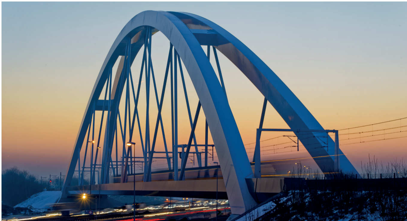
图 1 Zandhazen 铁路桥 – 斜吊杆系杆拱桥
