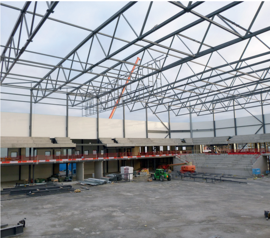
图5. 安装到位的主竞技场跨度 52 m 的桁架。 图片来源：由 Ruukki 提供
