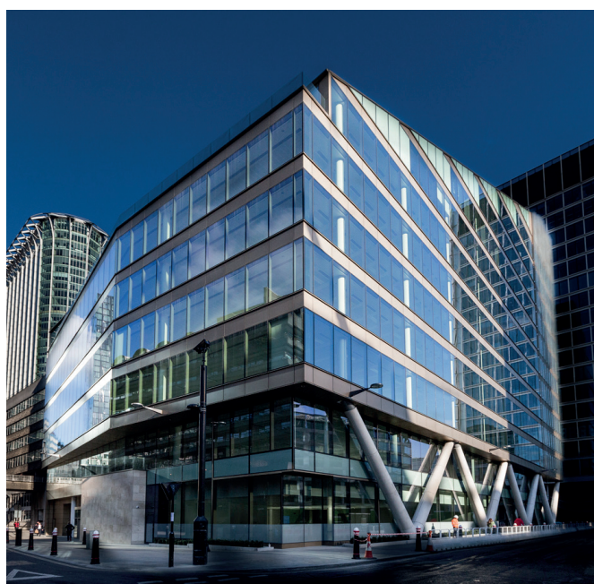
图 3 地面和二楼之间的 V 形支柱结构 资料来源：Tata Steel
