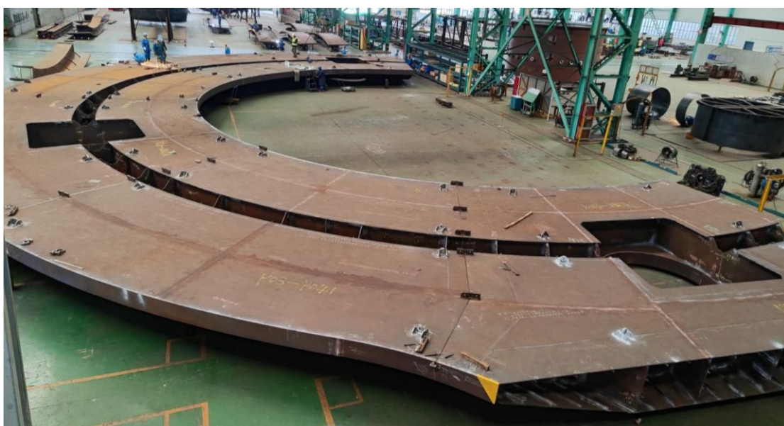
香港粉岭绕道东段项目单车径暨人行钢桥半圆于厂房预拼装
