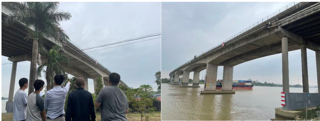
图 2.35 广州北斗大桥现场调研。
