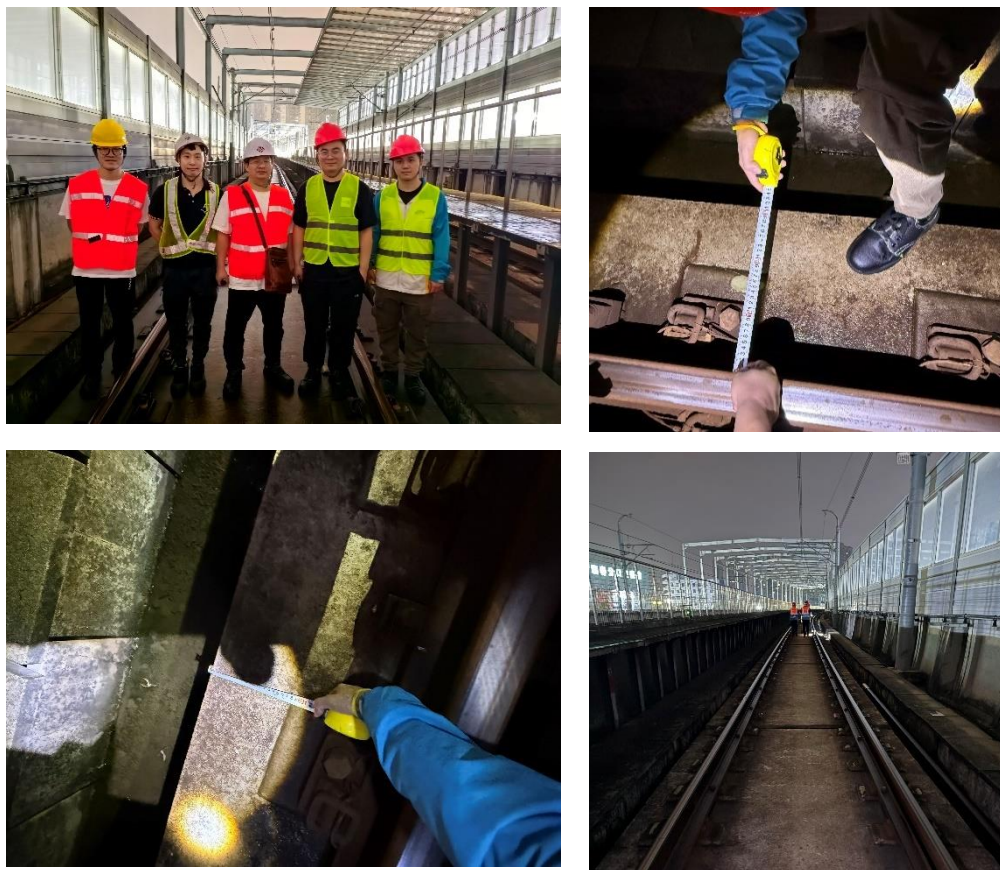
图 3.30 铁路工程香港分中心人员访问深圳市地铁集团有限公司 11 号线现场
