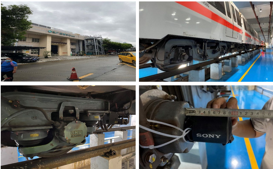
图 2.15 车厂控制中心勘察
