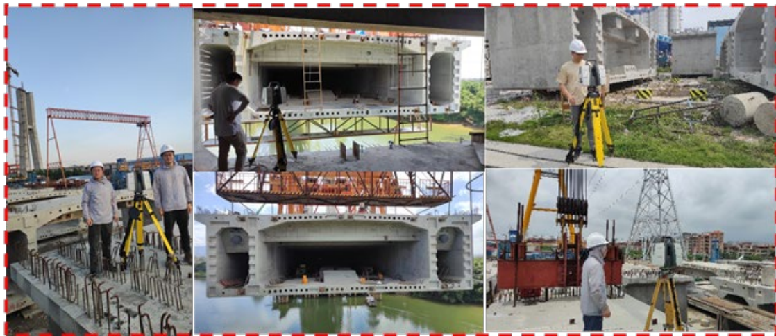
图 2.18 广汕高铁增江特大桥施工现场扫描工作
