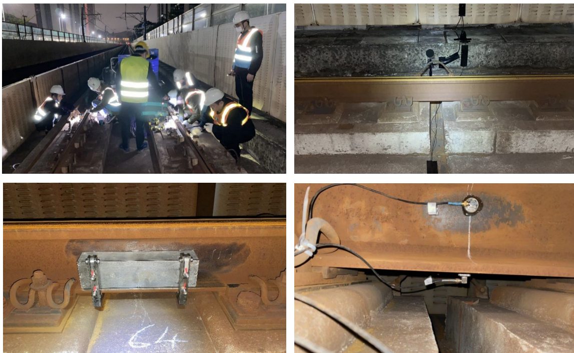
图 2.4 深圳地铁 5 号线塘朗城站路高架桥区段钢轨颗粒阻尼器安装与测试
