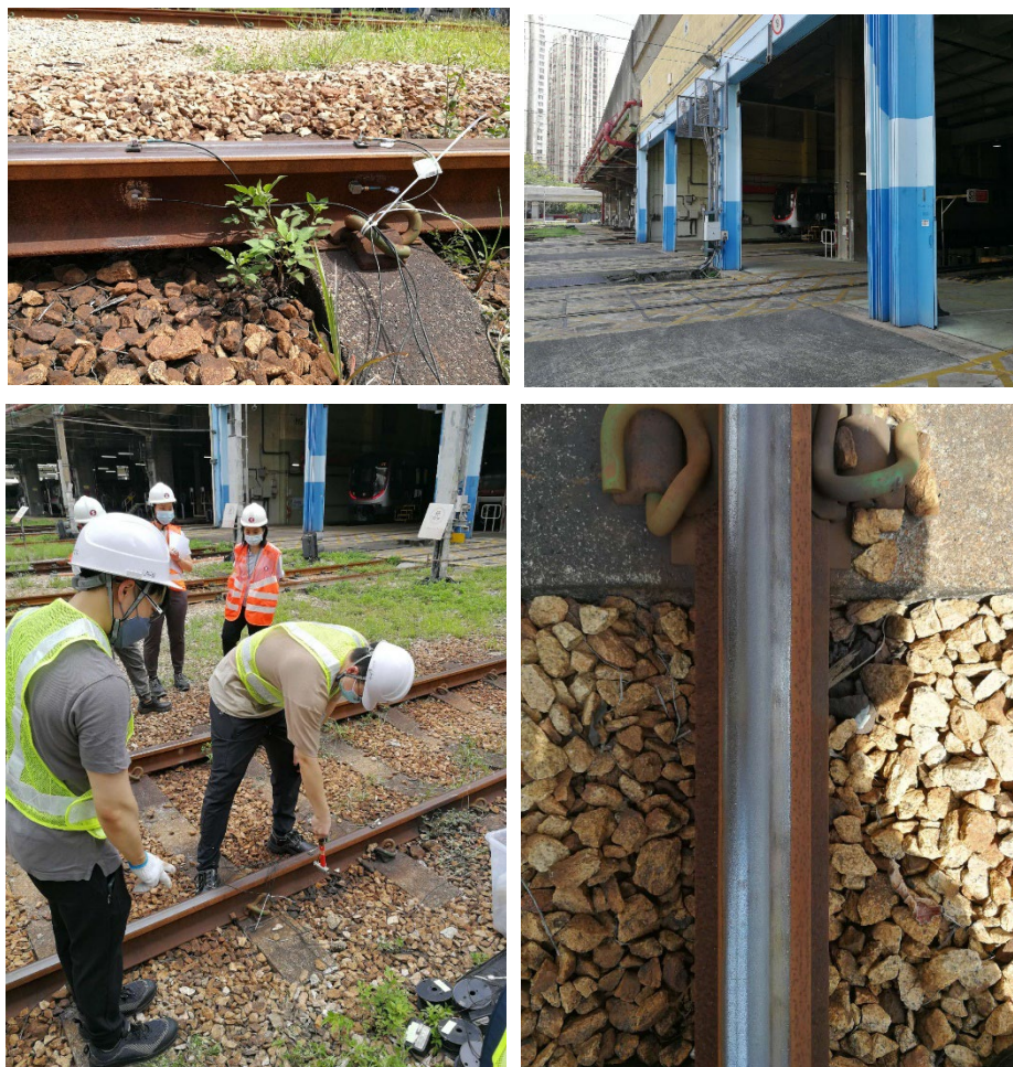
图 2.6 九龙湾车厂现场钢轨测试
