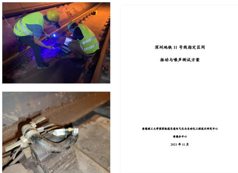
图 2.14 深圳地铁 11 号线现场测试情况
