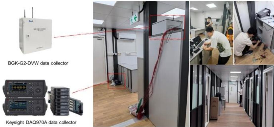
图 2.26 在香港元朗现场监测系统的安装调试
