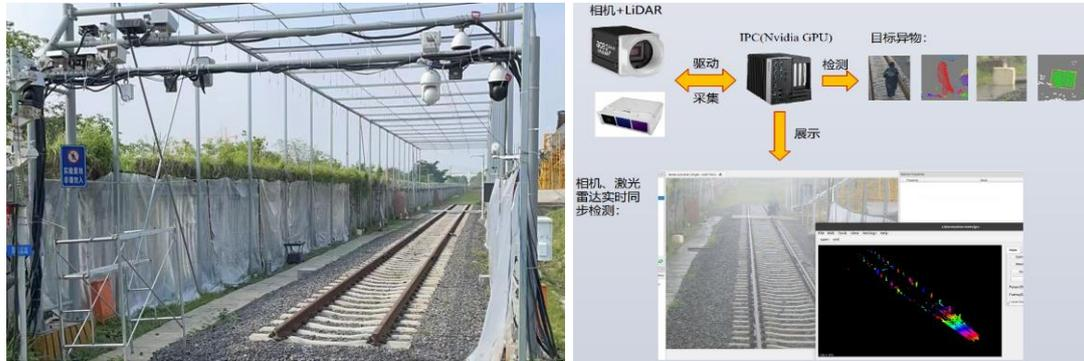
图 2.12 异物入侵检测系统现场安装及测试示意图
