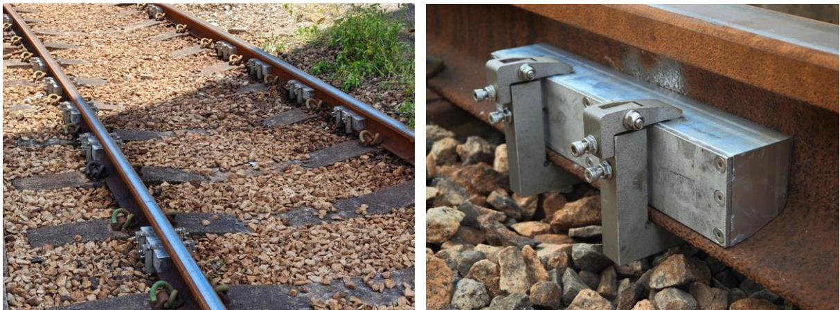
图 2.8 阻尼器现场安装示意图
